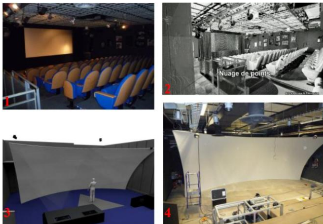
1. Salle avant travaux 2. Numérisation 3D de la salle 3. Modèle numérique d'étude 4. Installation de l'écran dans la salle.
