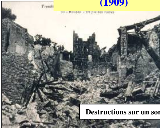
Séisme de Lambesc (1909)
